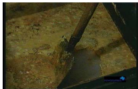
Фиг.2. Мазноуловител преди почистване
